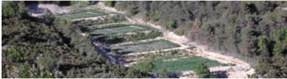
Station d'épuration par filtres plantés de roseaux
