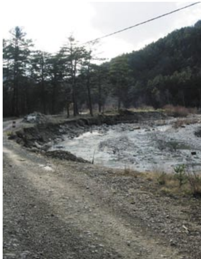
Erosion de berge sur le Jabron
