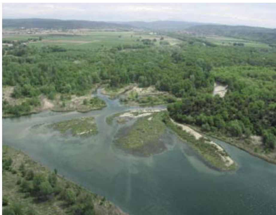
Fermeture du lit en amont de la confluence avec la Durance
