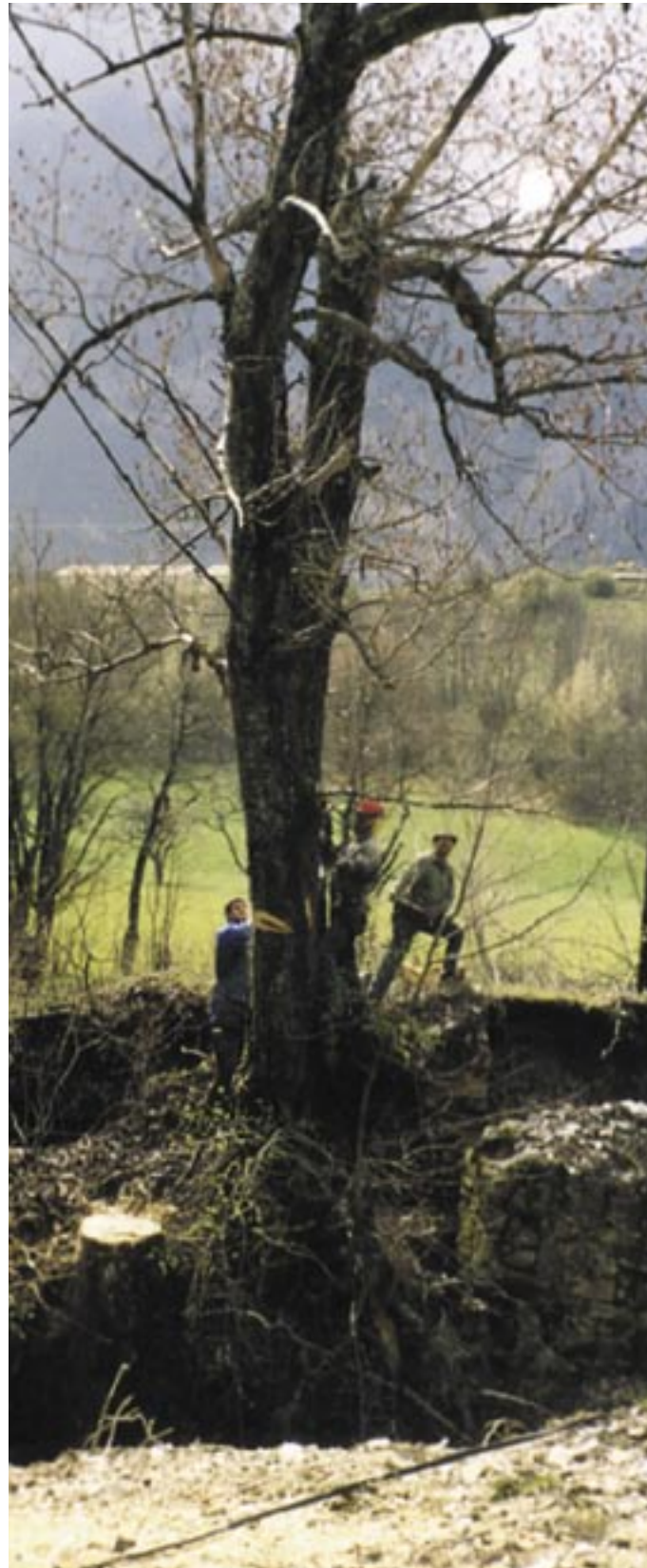
Travaux d'entretien de la ripisylve
