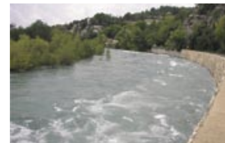
Aval du barrage de Gréoux à 200 m3/s
