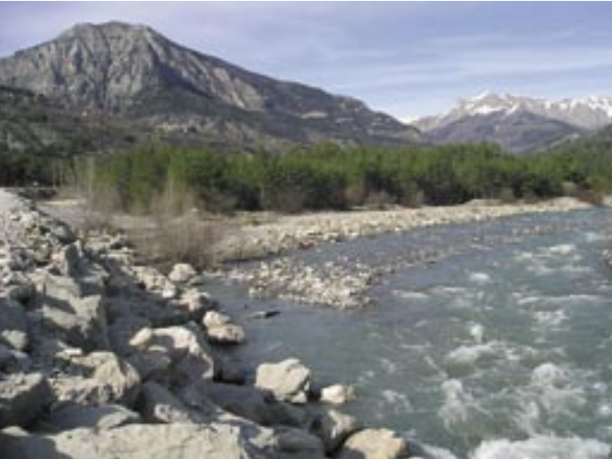
Enrochement sur le Haut Verdon
