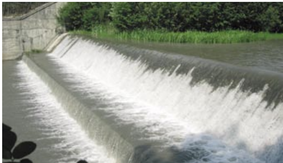
Seuil EDF en aval du barrage de Chaudanne
