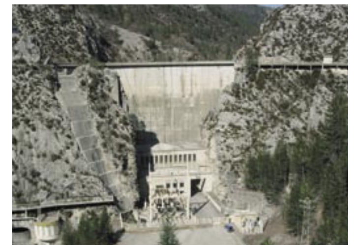
Le barrage de Chaudanne
