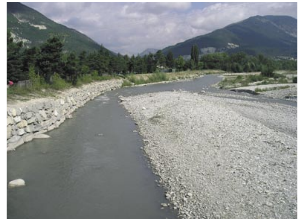
Protection de berge sur le Haut Verdon
