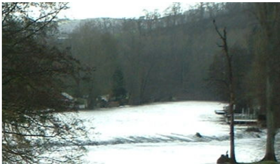
Photo 3 : Barrage au niveau du Moulin du Vey
