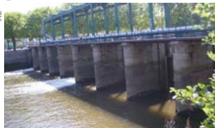
Barrage de Montviet sur l'Orne à Caen
