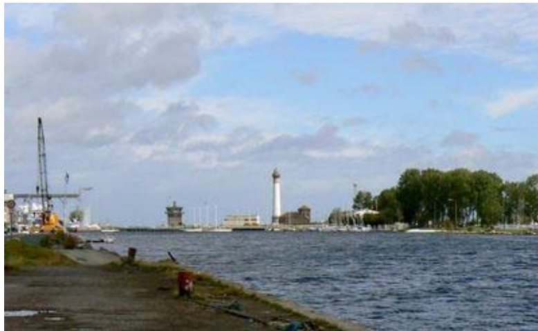
Canal du port de Caen-Ouistreham vu depuis le quai aux engins © IIBO
