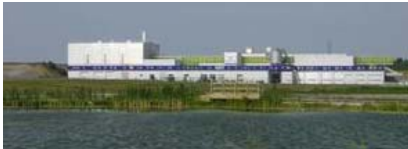
Station d'épuration du nouveau monde © Communauté d'agglomération Caen la mer
