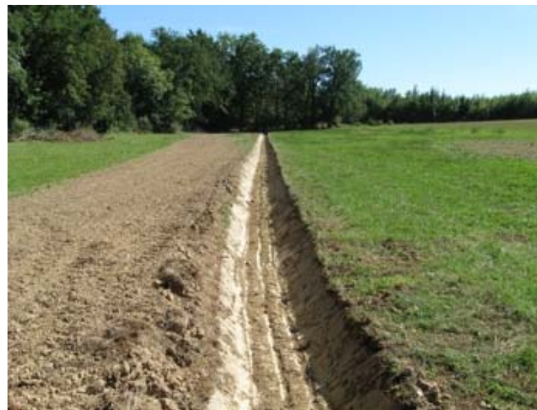
Fossé de drainage en zone humide © Pôle National Zones Humides
