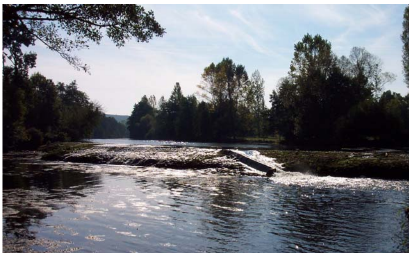
Barrage vétuste et non fonctionnel de la Mousse, en barrage du cours de l'Orne (14) © IIBO
