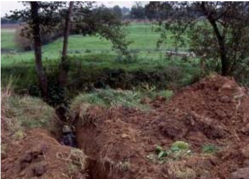
Drainage pour assainir une parcelle en bordure de cours d'eau © CATER de Basse-Normandie
