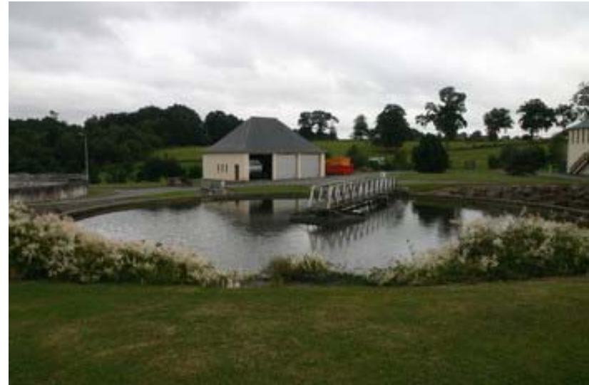
Station d'épuration du Landis © Communauté d'agglomération du Pays de Flers
