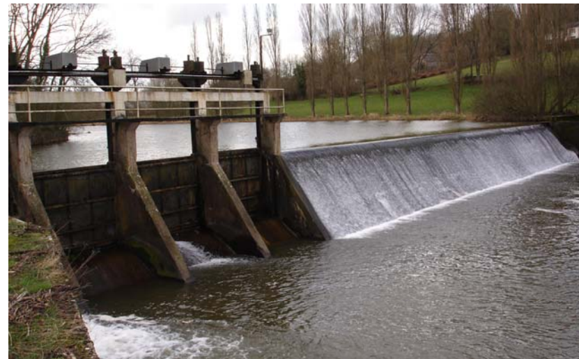
Usine de Brioux (14) © IIBO
