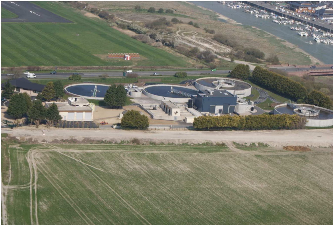
Photo 29 : La station d'épuration du SIVOM de la Région d'Étaples
