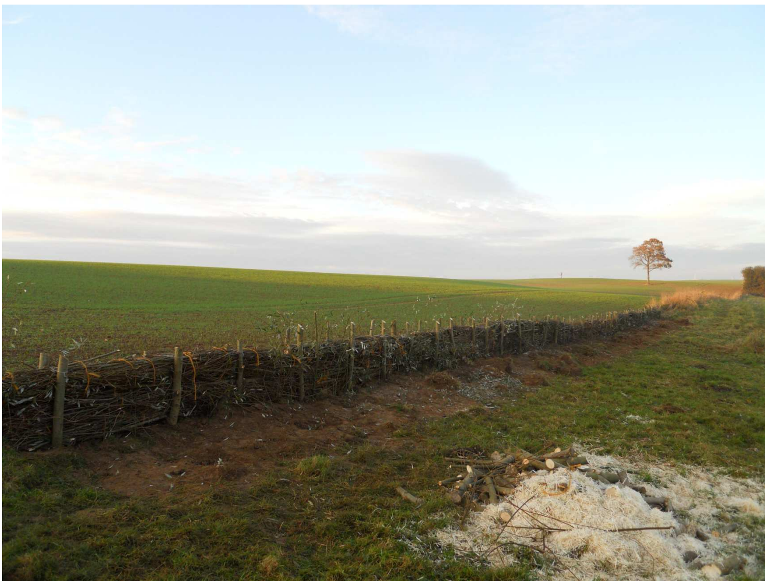
Photo 33 : La fascine, un ouvrage léger pour la lutte contre l'érosion des sols et le ruissellement
