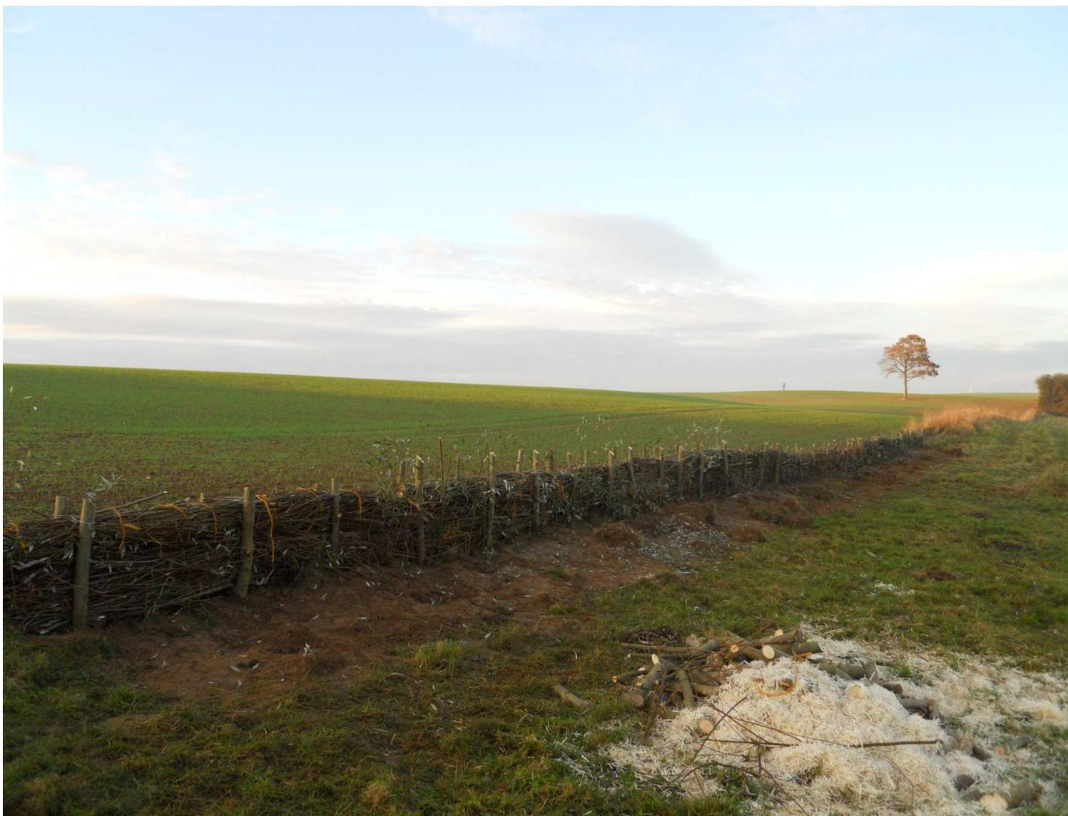
**Photo 37 : La fascine, un ouvrage léger pour la lutte contre l'érosion des sols et le ruissellement**
