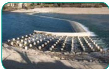
Reconstruction du seuil de Remoulins détruit par la crue de septembre 2002, avec ajout d'une passe à poissons (2007 - 2 000 000 €)
