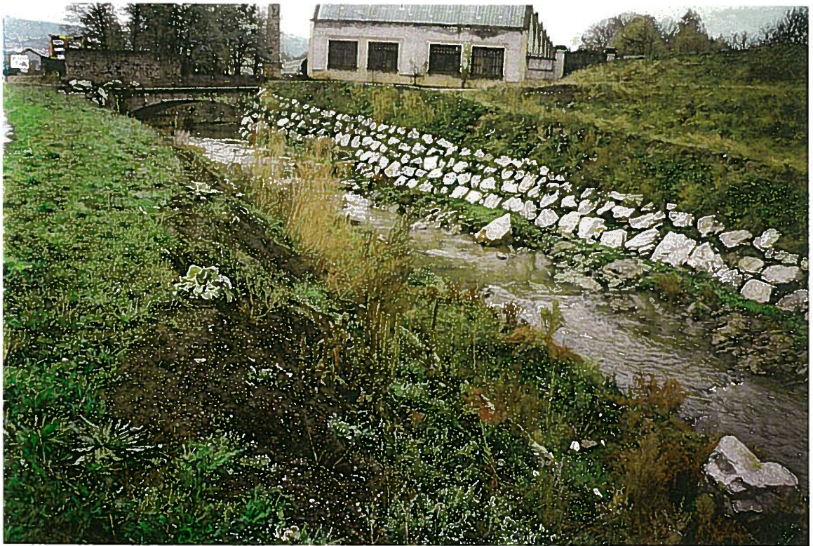
L'Ondaine : lit dévié au niveau de la déviation routière d'Unieux
