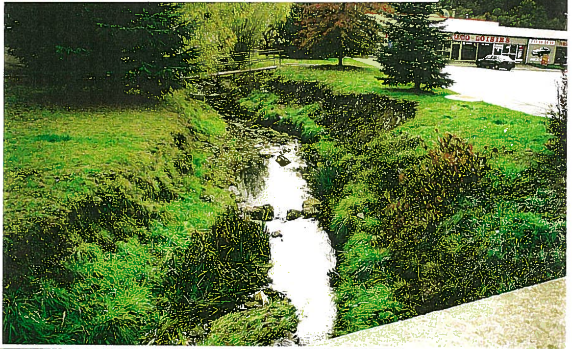
L'Egotay à l'aval du pont d'Unieux
