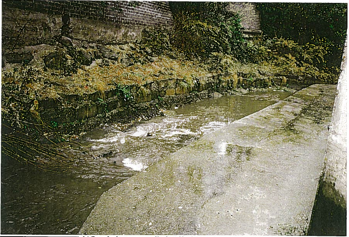
L'Ondaine vers l'abattoir de Firminy : "banc" provisoire pour le passage du collecteur du SIVO
