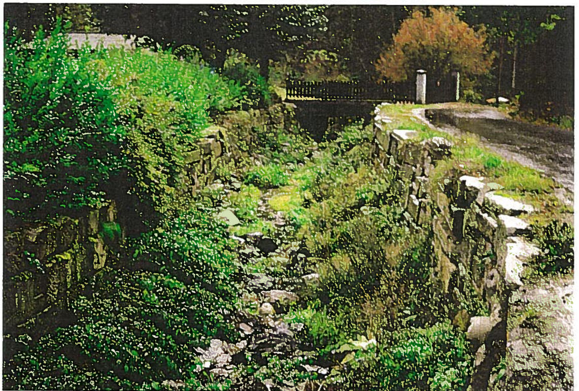
Enrochements sur le Cotatay, vers le secteur de Notre Dame de Cotatay
