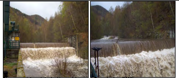
Chasse expérimentale de désensablement à Escouloubre (2009)
