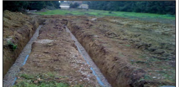
Tranchée d'épandage (cliché SPANC66)
