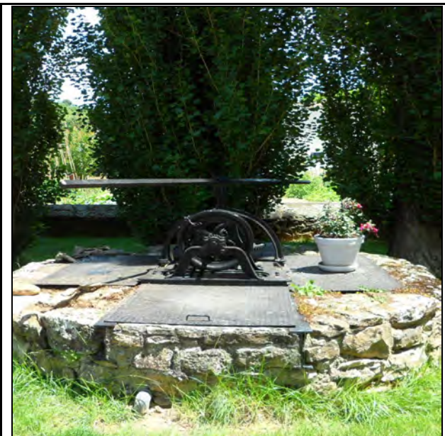
Puits privé à Montazels
