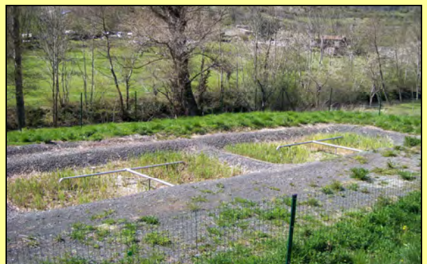
Station d'épuration à lits plantés de roseaux à Joucou
