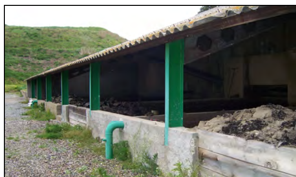
Stockage des boues de la station d'épuration de Matemale
