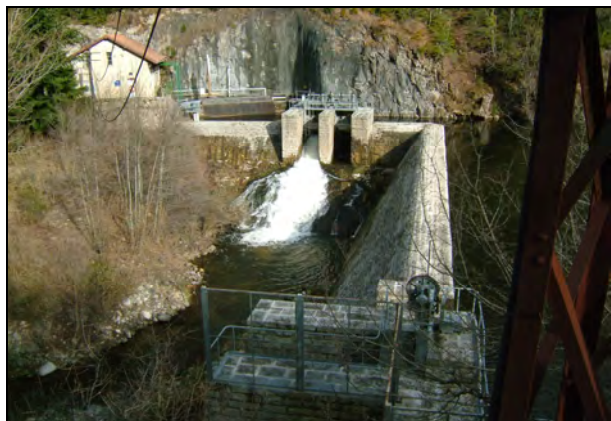
Débit réservé à la prise d'eau de Gesse
