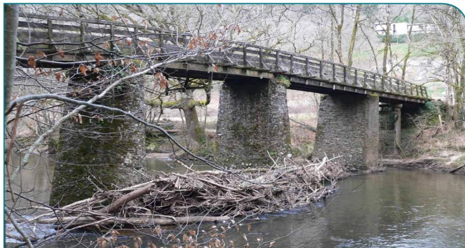
Embâcle dans le lit du Célé, pouvant provoquer des risques en termes d'activités nautiques et de sécurité des ouvrages
