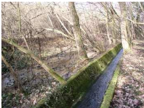
Photo 7 : le Ruisseau de l'Anneau bétonné à Saint-Ail en février 2004 (source : Sinbio).
