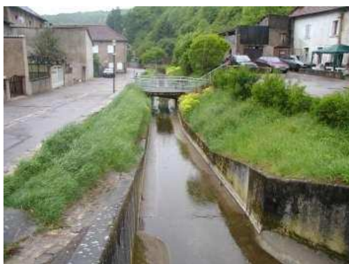
Photo 8 : la Fensch bétonnée à Fontoy en mai 2003 (source : Sinbio).
