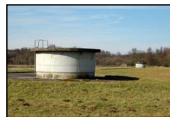
Puits du SMEB
