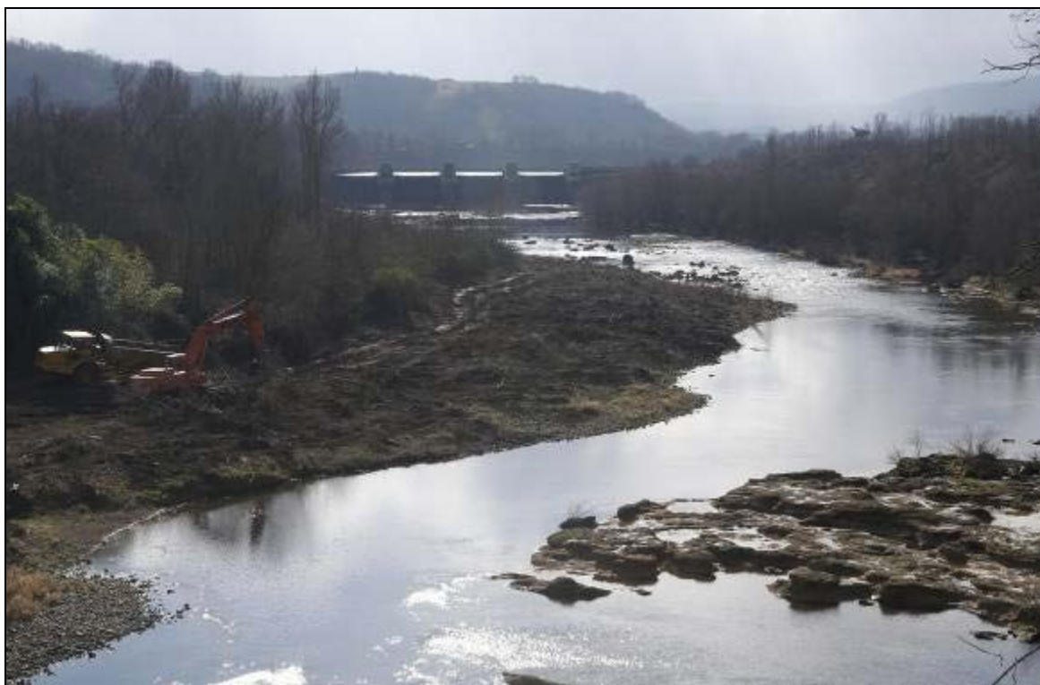
Travaux de restauration du méandre de Gensac, 2008 (© D. Taillefer – SMEAG)
