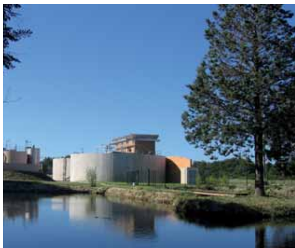
Station d'épuration de Cabriès - Mise en service en 2008
