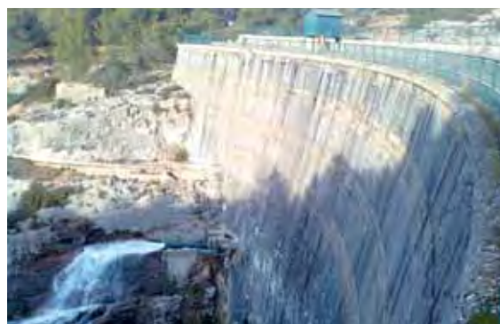
Vidange du barrage Zola
