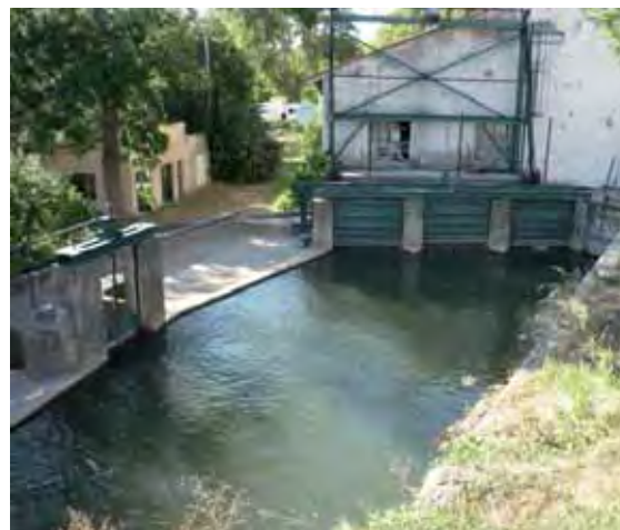
Micro-centrale hydroélectrique de Moulin du Pont
