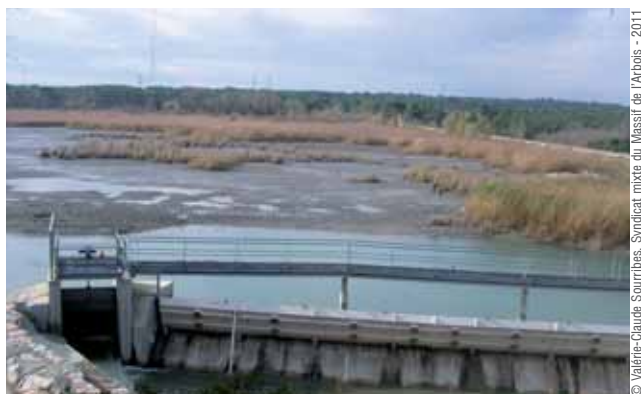
Déversoir de crue du bassin du Réaltor
