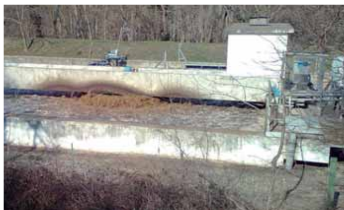
Station d'épuration des Milles
