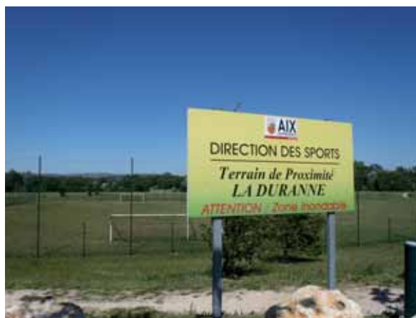
Bassin de rétention "multi-usages"
