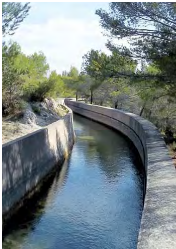
Canal géré par la Société du Canal de Provence - dérivation des eaux du Verdon
