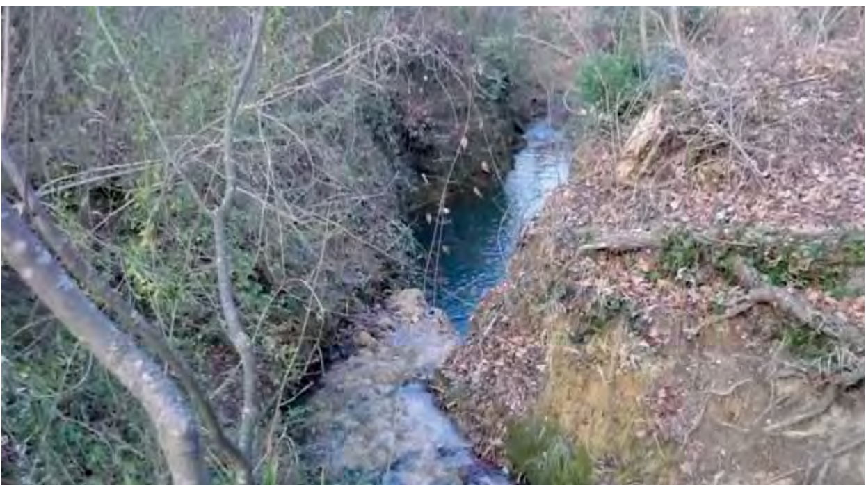
Enfouissement du lit du Grand Torrent
