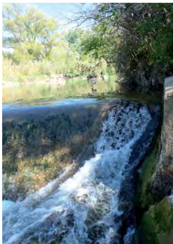
Rampe à anguille - Seuil de Gordes
