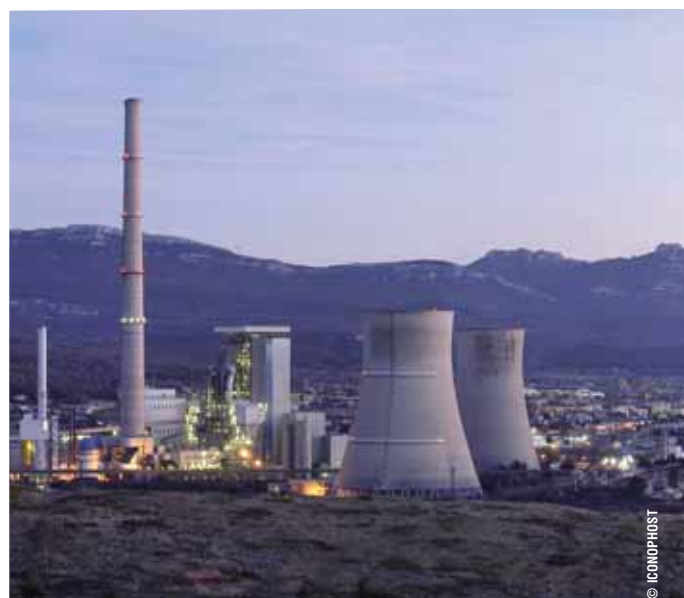
Centrale thermique à Gardanne
