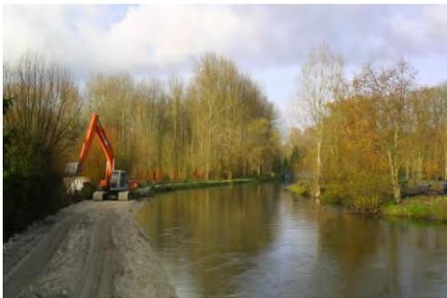
Figure 169 : Renforcement des berges de la Somme canalisée
