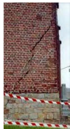
Figure 179 : Fissure sur une église suite aux mouvements de terrain
