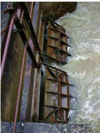
**Photographie 12 : clapets anti-retour de l'écluse de La Poterie Chaillevette.**
