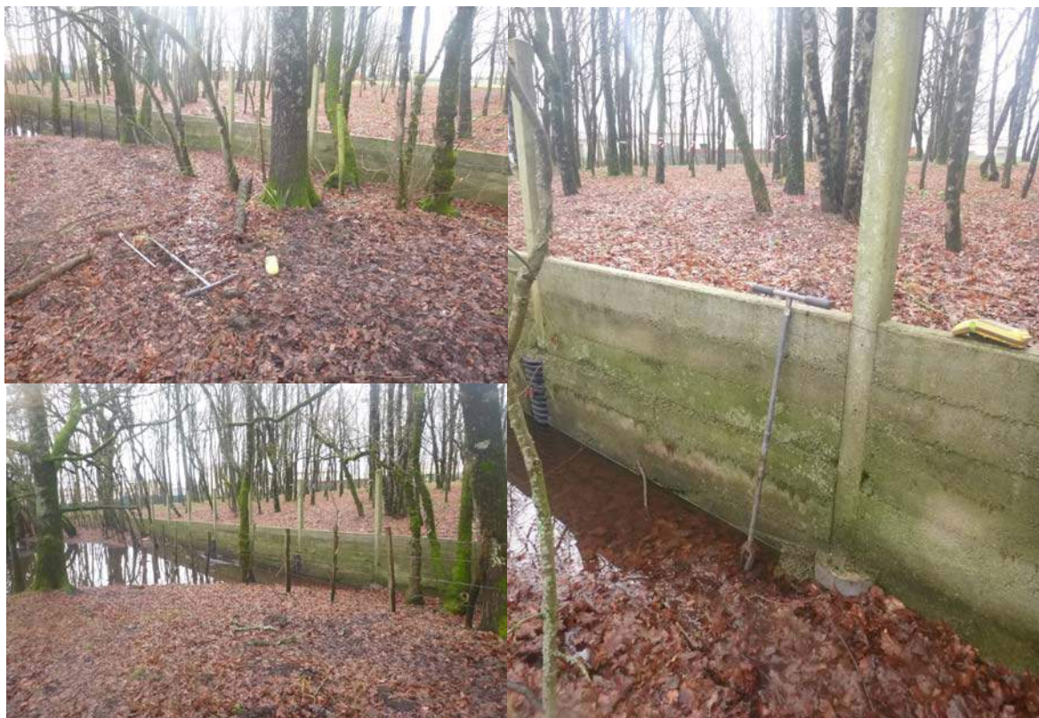
Photo 26 : Partie remblayée de la zone humide du « Bois des Chagnasses »
