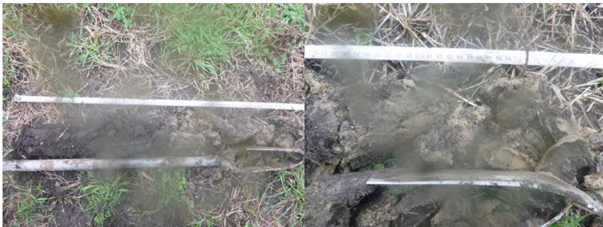
Photo 16 : Sondage n°1, secteur de M. CORPRON (Zone 6)
