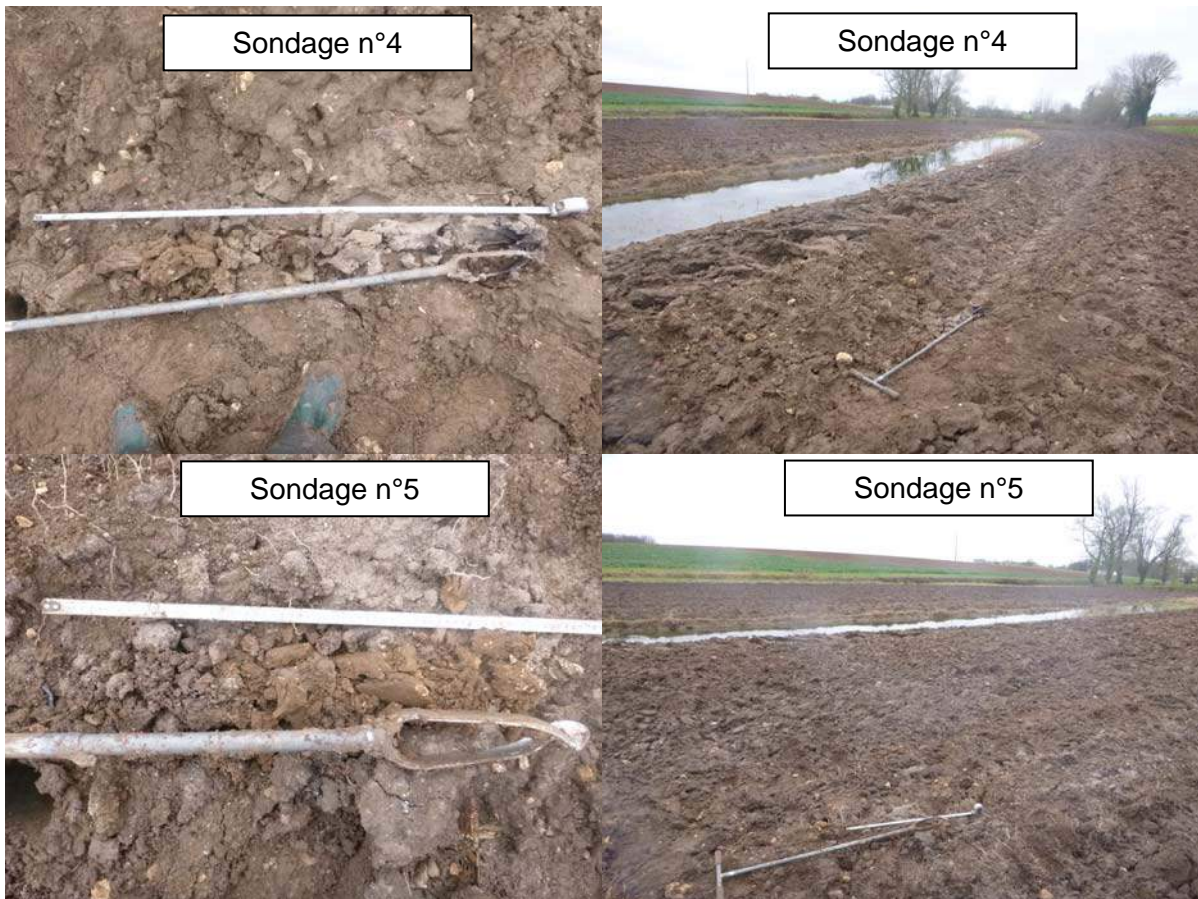
Photo 14 : Sondage, secteur de M. BRIDIER, aval de la route (Zone 5)
