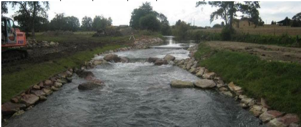
Figure 9: Exemple de rivières de contournement avec bassin intermédiaire (14)
