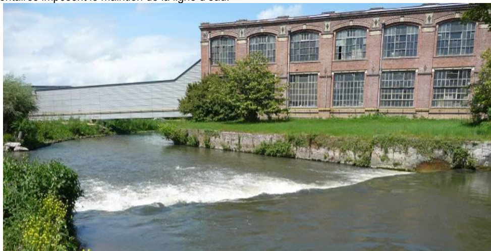
Figure 5: Exemple d'arasement partiel avec pré-barrages sur la Risle (27)
