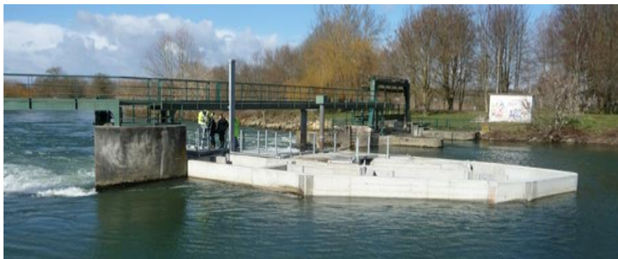
Figure 6: Exemple de passes à poissons en génie civil béton sur la Charente à Cognac(16)
