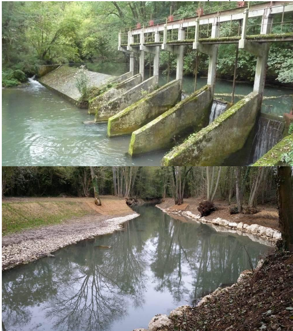
Figure 3: Exemple d'effacement avec conservation d'un faciès lentique à l'ancien moulin de Montblin sur le Grand-Morin (77)
