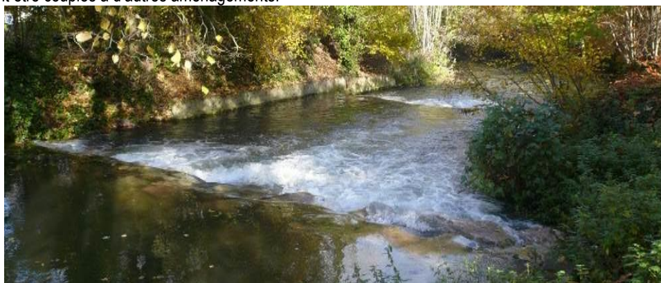
Figure 7: Exemple de pré-barrages sur la Risle à Brionne (27)
