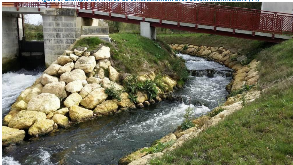
Figure 10: Exemple de bras de contournement du barrage de l'Houmée sur la Boutonne (17)
