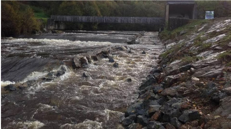
Figure 8: Exemple de rampes rustiques sur le Léguer (22)
