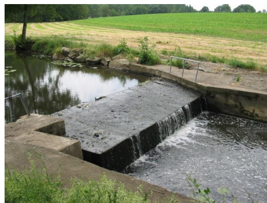
Figure 14 : Barrage de la Villette
