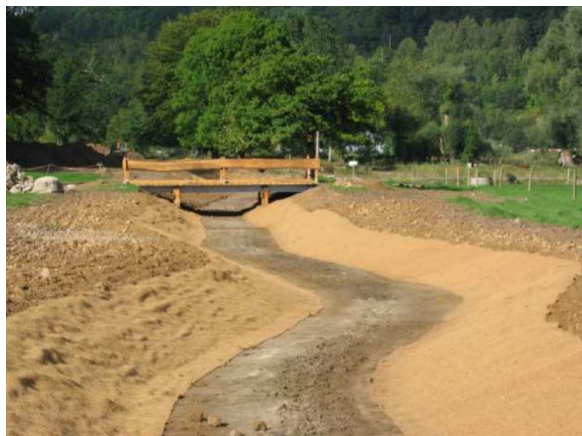
Création de passerelles et pose d'un géotextile
