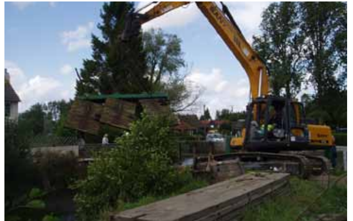
Figure 3 : démontage des vannages de l'ancienne pisciculture de Merck-Saint-Liévin (Crédit photographique : SmaeAa)
