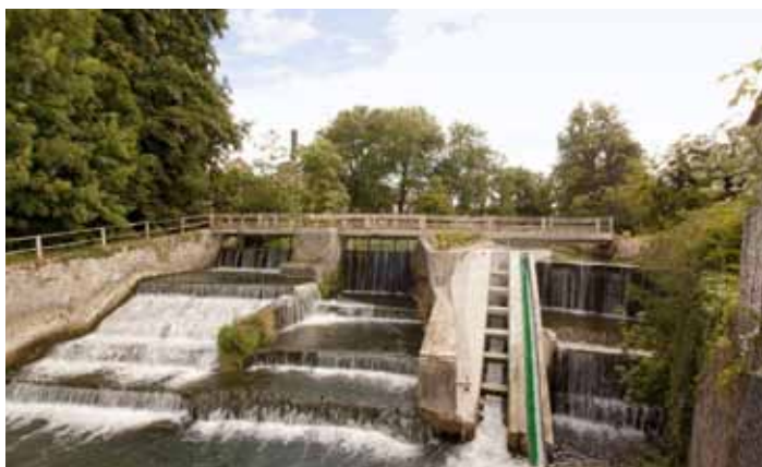
Barrage après travaux, vue de l'aval (Source : AEAP)
