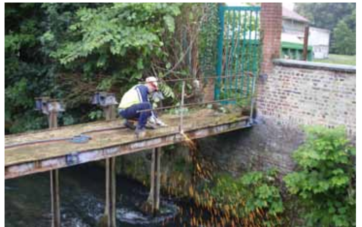
Figure 4 : ancien moulin de Norampac-Avot (Crédit photographique : SmaeAa)
