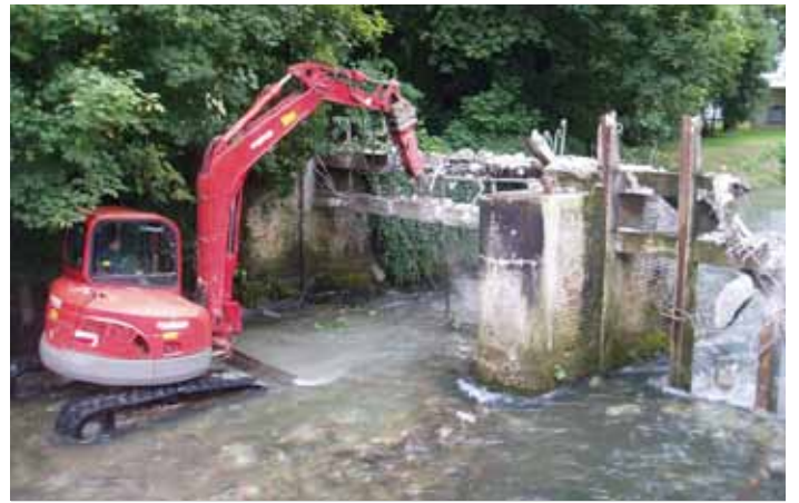
Figure 2 : démontage de l'ancien vannage de la SILL à Wizernes (Crédit photographique : SmaeAa)
