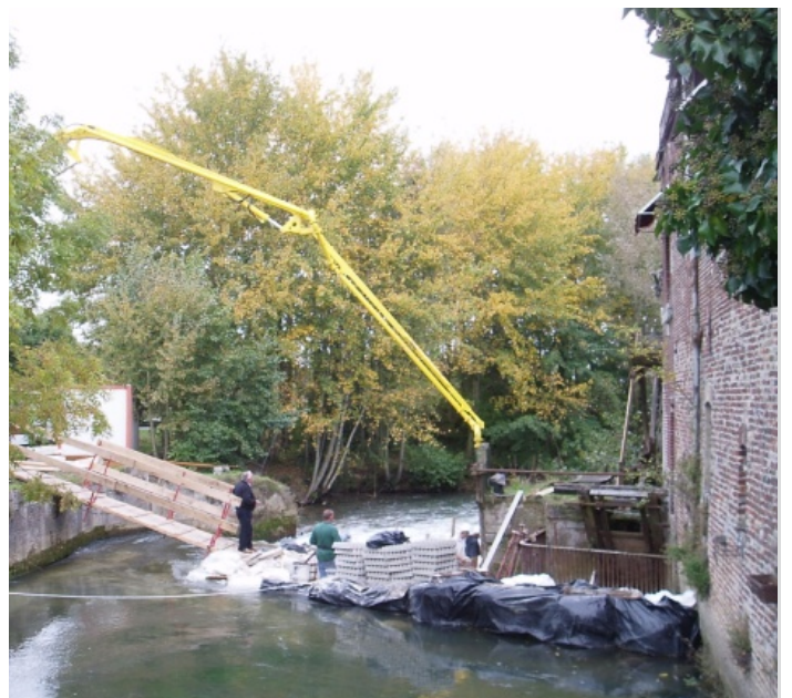
Travaux de maçonnerie (Crédit photo : SmageAa)
