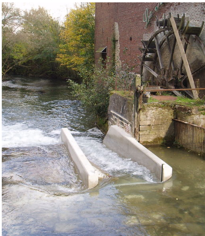
Moulin Snick après travaux (Crédit photo : SmageAa)
