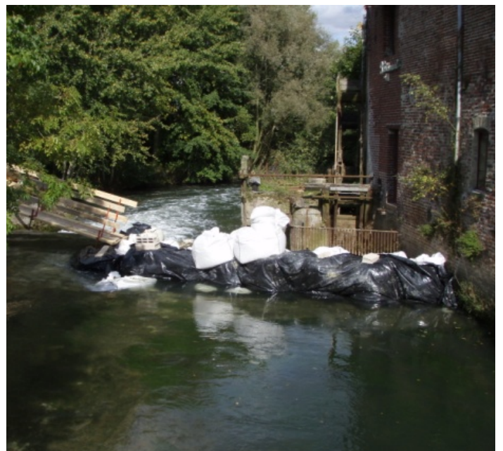
Construction de la passe à poissons (Crédit photo : SmageAa)
