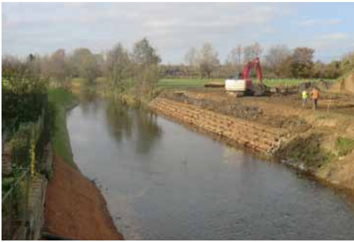
Site en travaux (Source : DREAL)
