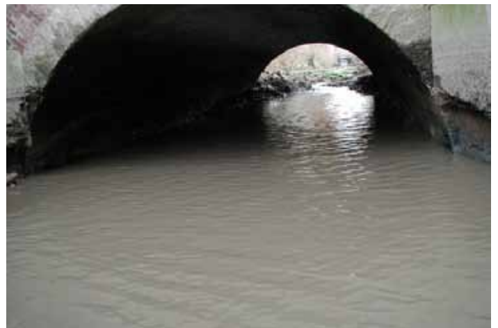
Figure 2 : le pont à proximité de l'ouvrage avant et après travaux (Crédit photographique : S.M. SAGE Canche)
