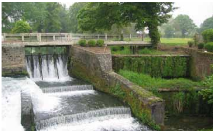
Barrage avant travaux, vue de l'aval (Source : AEAP)
