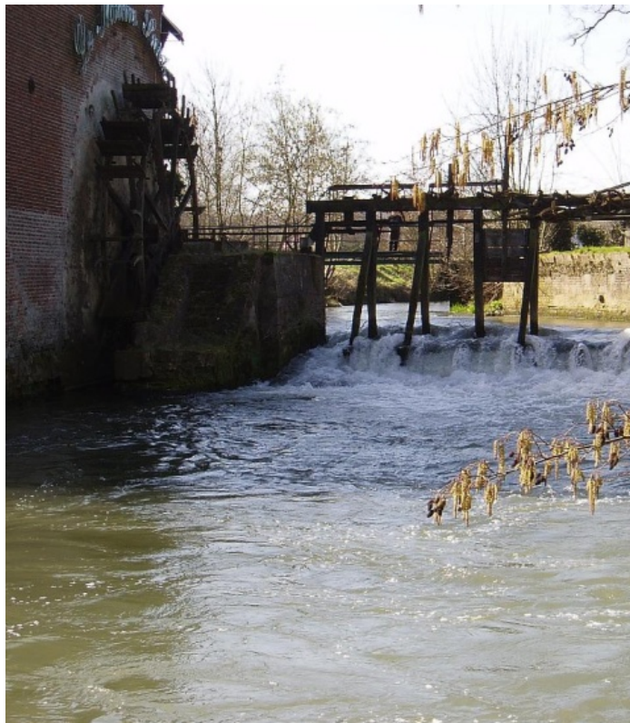
Moulin Snick avant travaux (Crédit photo : SmageAa)
