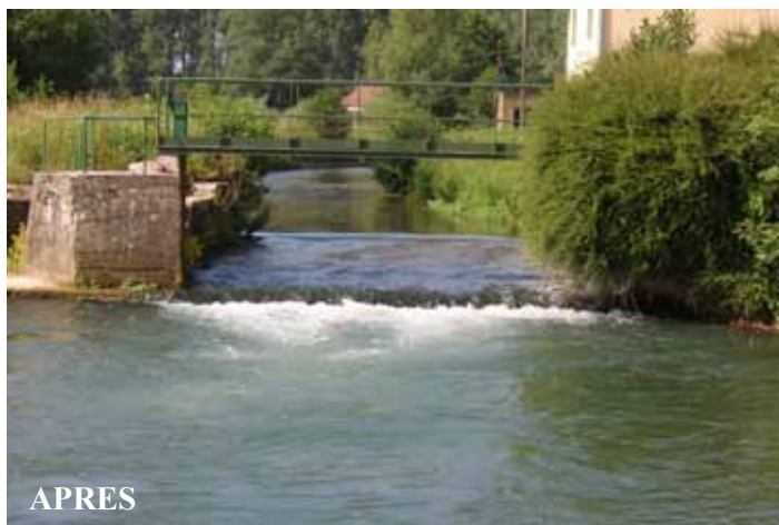
Figure 6 : barrage de Merck-Saint-Liévin avant et après travaux (Crédit photographique : SmageAa)
