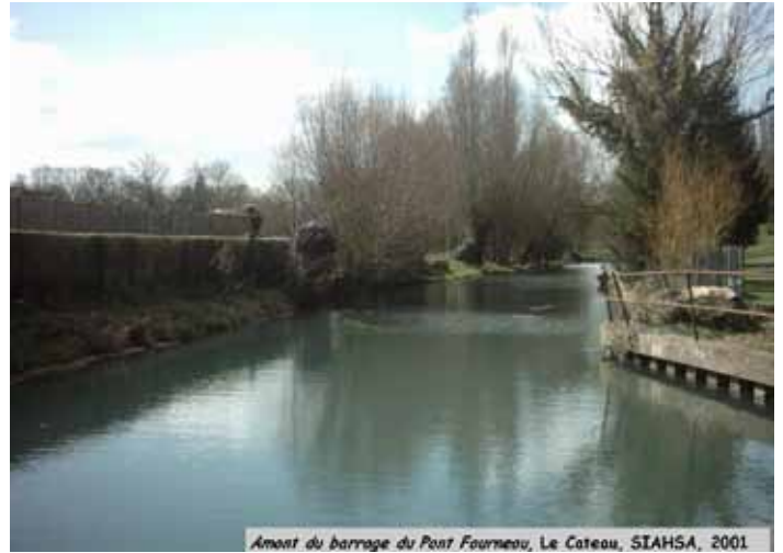
Amont du barrage du Pont Fourneau, Le Coteau, SIAHSA, 2001
