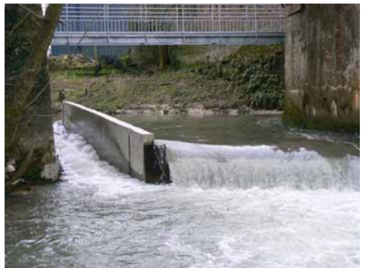
Ouvrage de Teneur après travaux (Crédit photographique : S.M. SAGE Canche)
