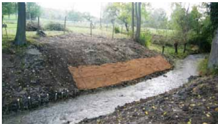
Pose de géotextile (Crédit photographique : FDAAPPMA 62)
