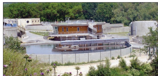
Station d'épuration de Salon-de-Provence
