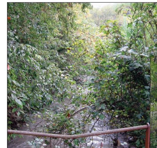
La Touloubre AVANT restauration
