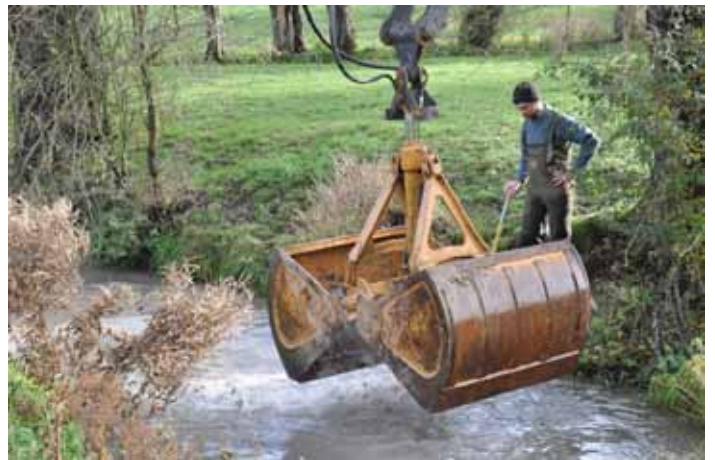
Recharge granulométrique en cours (crédit photo : FDAAPPMA 59)
