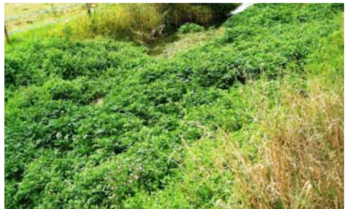
Obstruction du lit par la végétation
