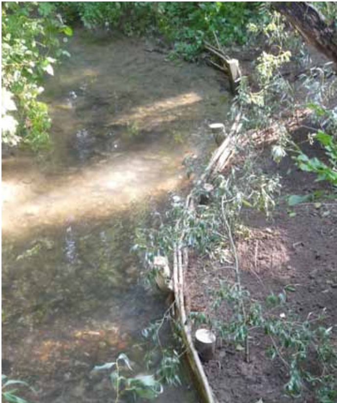
Rétrécissement de la section mouillée par création d'un épi (Crédit photo : FDAAPPMA 62)
