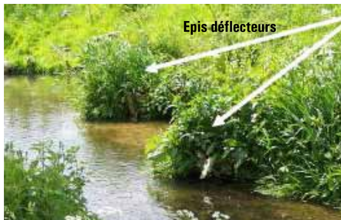
Mise en place d'épis déflecteurs (Crédit photographique : CRPF)
