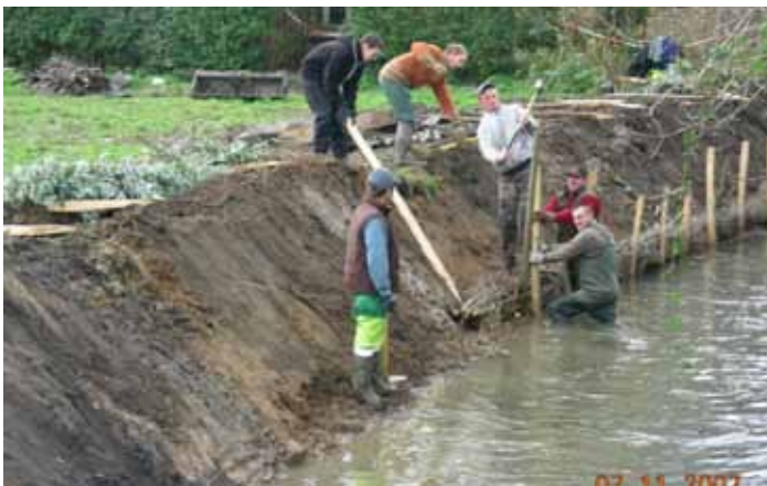
Mise en place des fascines de saules (Crédit photographique : Artois Comm)
