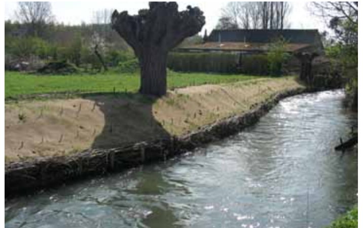
Pose de géotextile et bouturage (Crédit photographique : Artois Comm)
