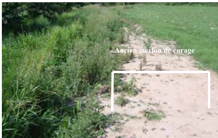
Arasement de l'ancien merlon de curage
