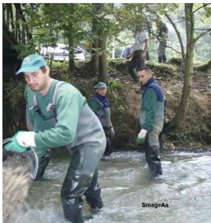
Mise en place des graviers 20-40 mm
