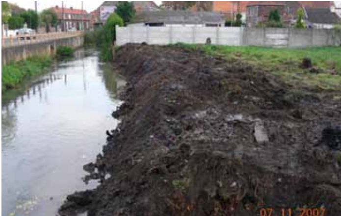
Retalutage des berges (Crédit photographique : Artois Comm)
