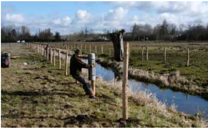
Pose de clôture (Crédit photographique : AMEVA)
