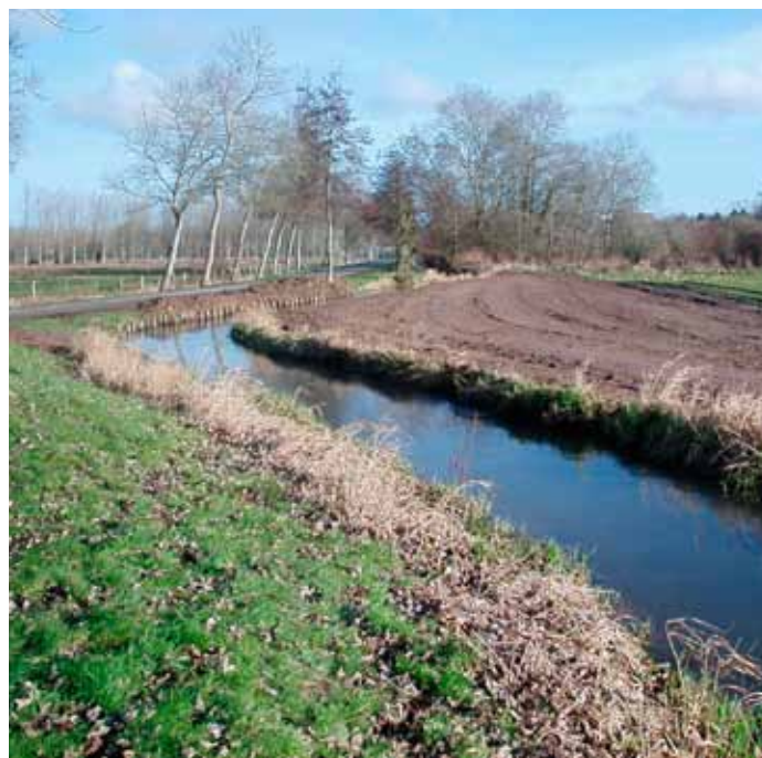
Travaux de terrassement, après travaux (Crédit photo : AMEVA)
