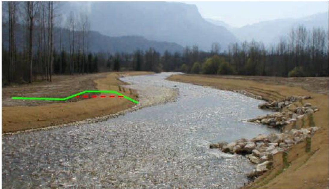
Illustration du principe 3 - abaissement de la berge rive gauche
