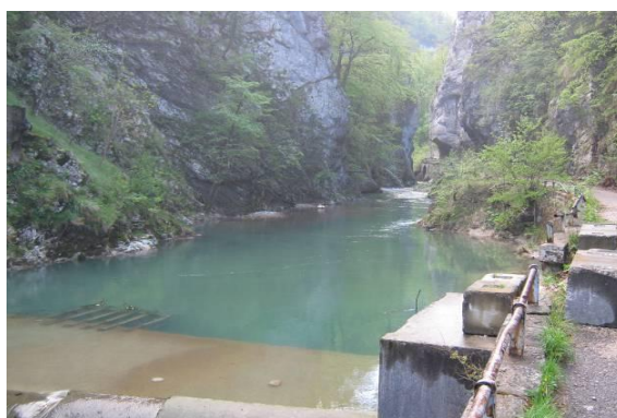
Traces de curages observées dans la retenue du barrage de Fourvoirie (GM5)
