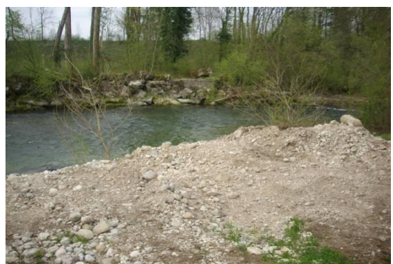
Récant curage dans la retenue de l'ouvrage Baffert (GV6)
