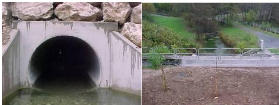
Le Gua en sortie du busage autoroutier
