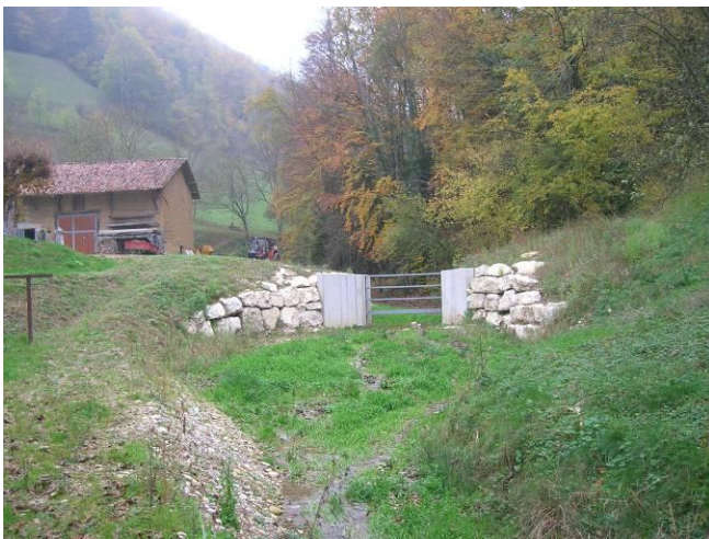
Plage de dépôts sur le rau. des Combes
