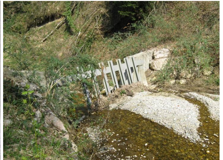
Piège à embâcles sur le Beauchiffray
