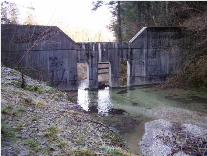
Piège à graviers de la Grotte sur le Chorolant
