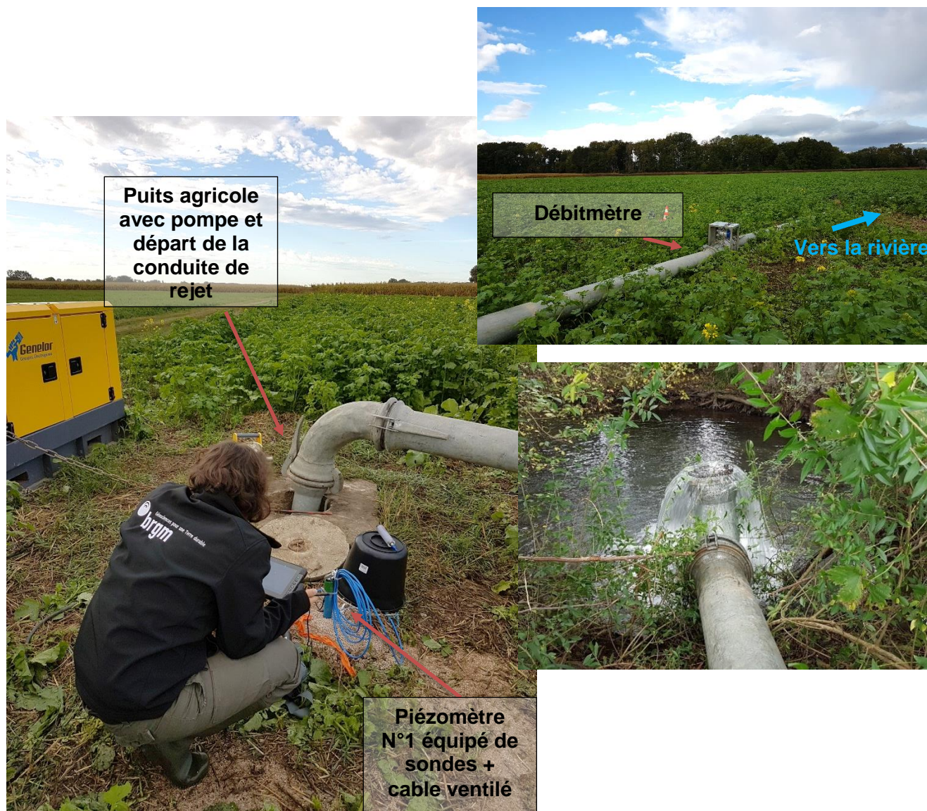
Figure 69 : Visualisation du site de pompage : puits agricole, conduite de rejet avec débitmètre magnétique, et déversement en champignon dans la rivière pour limiter l'impact hydrodynamique sur la rivière.
