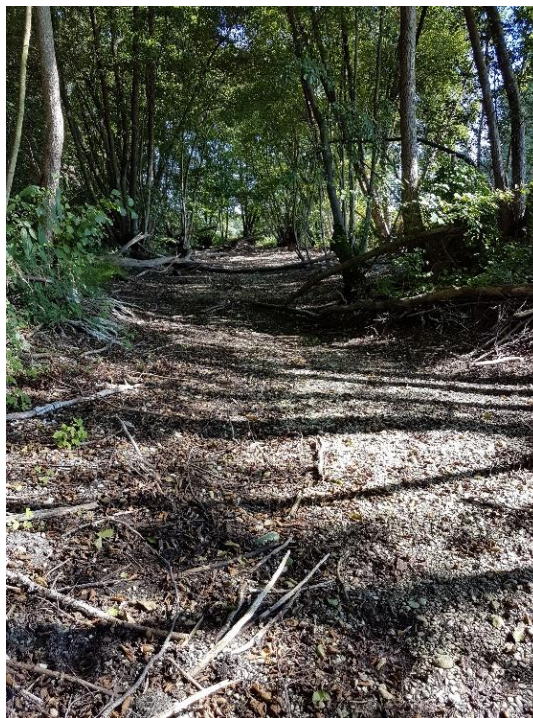
Figure 46 : Photo du Neugraben en assec (05/09/2019).
