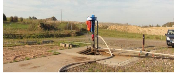
cimentation Tête de forage PCP (Folsh-2)
