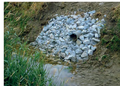
Sortie de drainage Source : Ontario, Ministère de l'agriculture, de l'Alimentation et des Affaires rurales, 2015.
