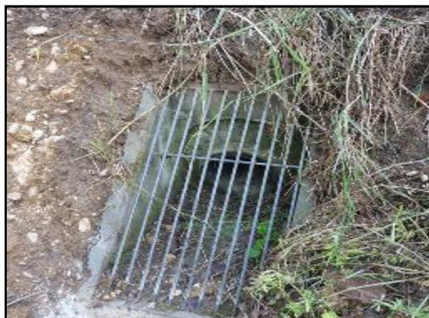
Figure 2 : Exutoire d'un collecteur de drainage
