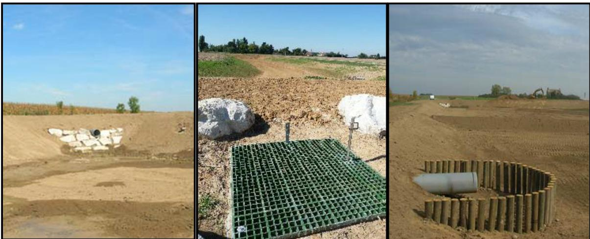
Figure 47 : Structure d'entrée, Seuil et vanne dans un regard, Structure d'évacuation
