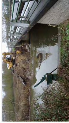
Suppression du barrage
