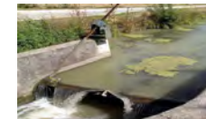
Ouvrage à crémaillère
