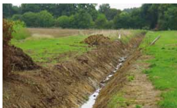
Exemple de suppression de drain - Source : CAMA
