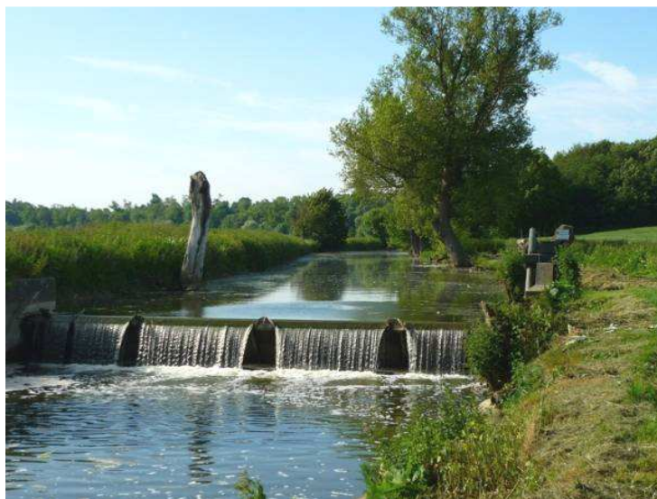
Vanne-clapet d'Evry-Gregy, le 6 juin 2009
