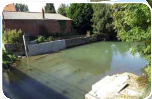
Nordausques après les travaux
