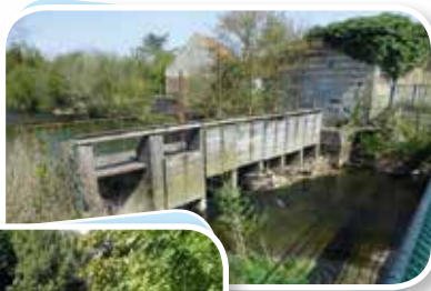
Nordausques avant les travaux
