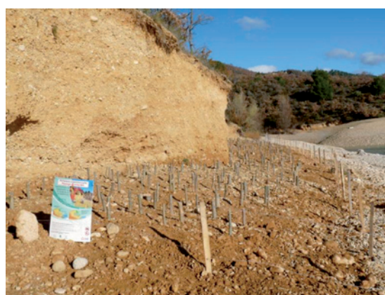
Pieux de Saules mis en place à Sainte-Croix du Verdon en novembre 2010
