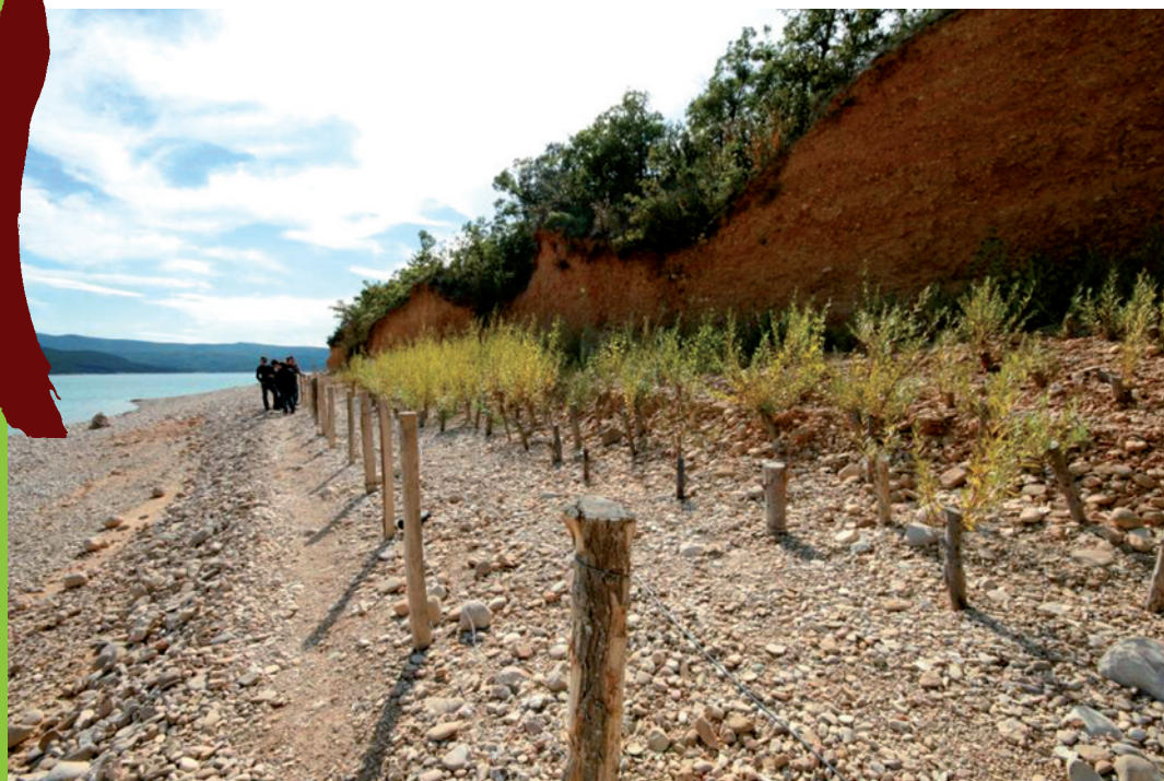
Pieux de saules et de peupliers mis en place à Sainte-Croix du Verdon en mars 2010
