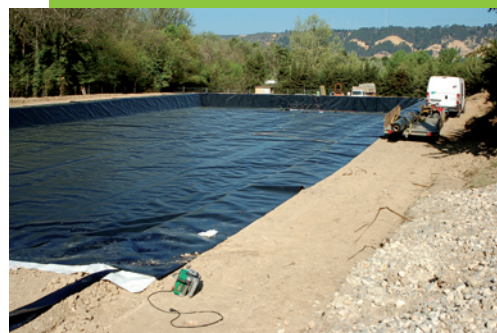
Construction de la nouvelle station d'épuration des Salles-sur-Verdon
