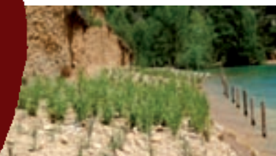
Protection des berges en génie végétal à Sainte-Croix
