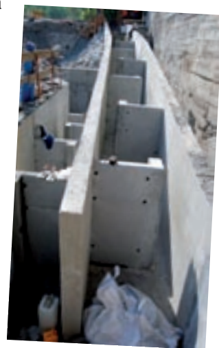
Construction de la passe à poissons sur un seuil à Castellane
