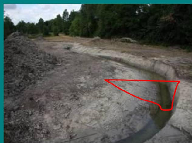
Un lit aux deux berges systématiquement en pente douce (fond de type « noue ») n'est pas non plus recommandable, cela entraîne généralement un agrandissement excessif du gabarit. Des ajustements avec colmatage sont également à attendre.
