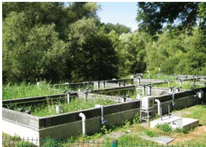
Installation pilote de Craonne : juxtaposition de modèles réduits non représentative de l'aspect d'un ouvrage à taille réelle.
