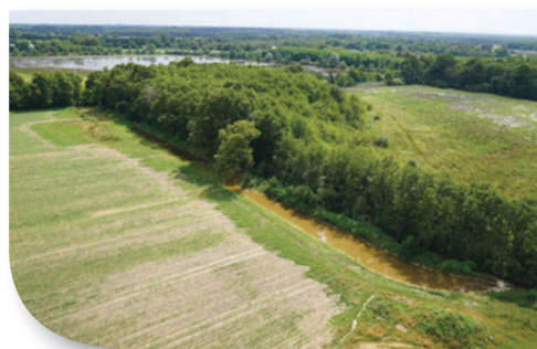
Fossé aménagé en zone de rétention à Saint-Nizier-le-Désert
