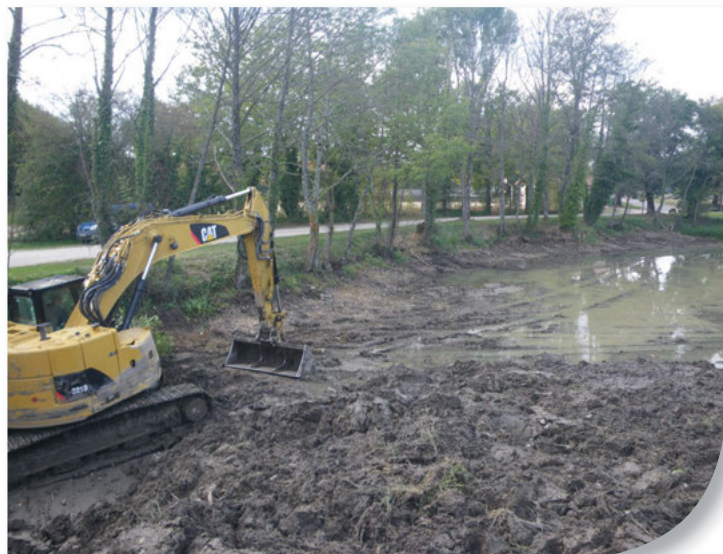
Travaux de curage du plan d'eau de Dompierre-sur-Veyle
