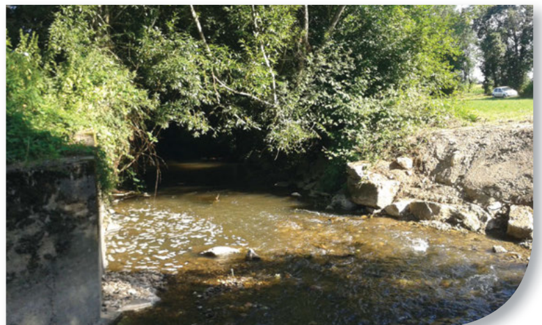
Le Renon au droit du vannage de la Poule après dérasement
