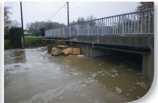
Ouvrage de décharge de la RD96 lors de la crue de novembre 2016
