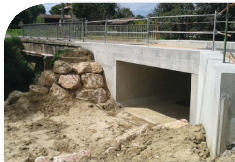
Ouvrage de décharge du pont de la RD96 après travaux
