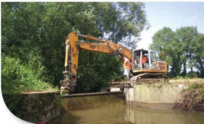
Le Renon au droit du vannage de la Poule avant dérasement
