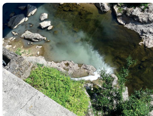
Rejet de canalisation d'eaux pluviales en rivière
