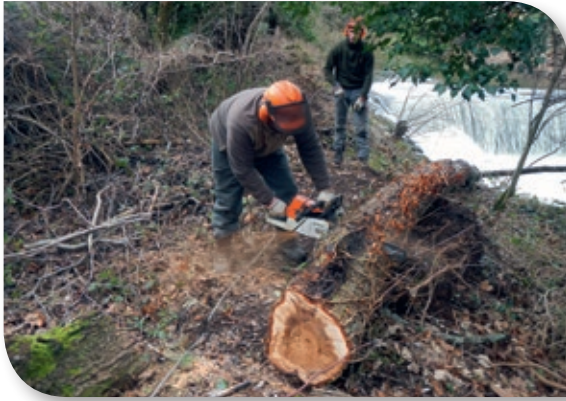
Abattage d'arbres instables en berge
