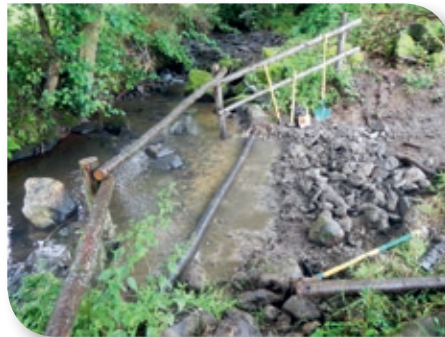
Pose des longrines pour délimiter la zone d'abreuvement
