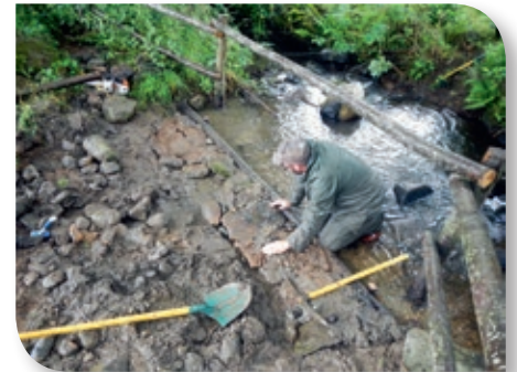
Réalisation du pavage en galets
