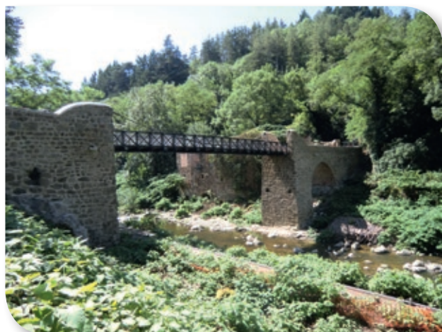
Pont suspendu de Moulin sur Cance restauré
