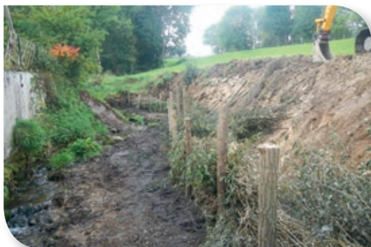
Pendant les travaux
