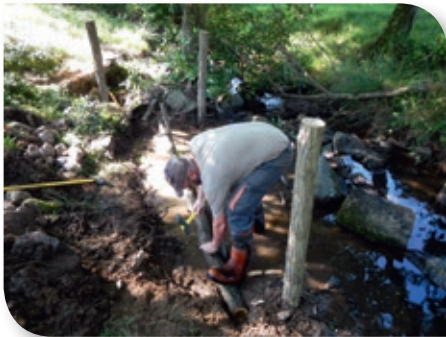
Installation des pieux et de la longrine au sol
