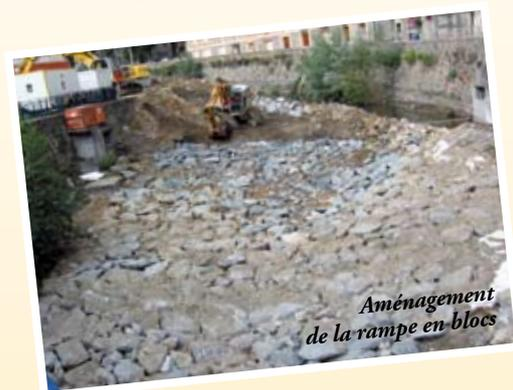
Les travaux ont débuté dans le lit de la Cance par l'agencement d'une rampe en bloc à la place du seuil existant. Ensuite, trois petits seuils de fond ont été réalisés afin de stabiliser et rehausser le fond du lit. Afin de compléter ces travaux, des blocs ont été installés pour diversifier le fond de la rivière (amélioration de l'habitat piscicole).
