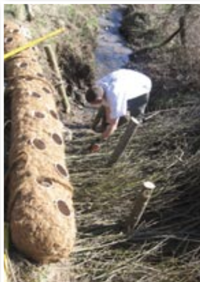
Mise en place de fascine de saules sur le ruisseau de Rigueboeuf Colombier
