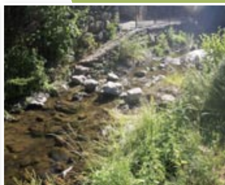
Passage en galet du ruisseau du Malbuisson Villevocance
