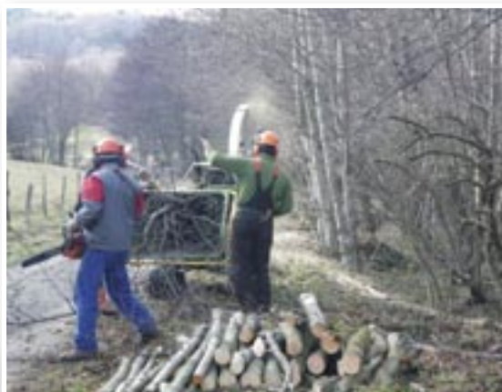
Restauration des berges sur le ruisseau de Riguebœuf - Colombier
