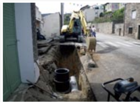
Travaux d'assainissement sur St Sauveur-en-Rue
