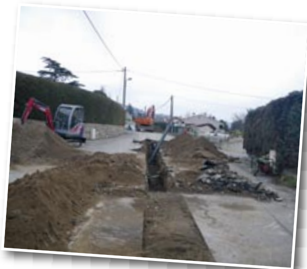
Travaux d'assainissement sur Boulieu
