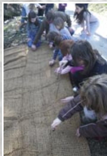
Fixation du géotextile
