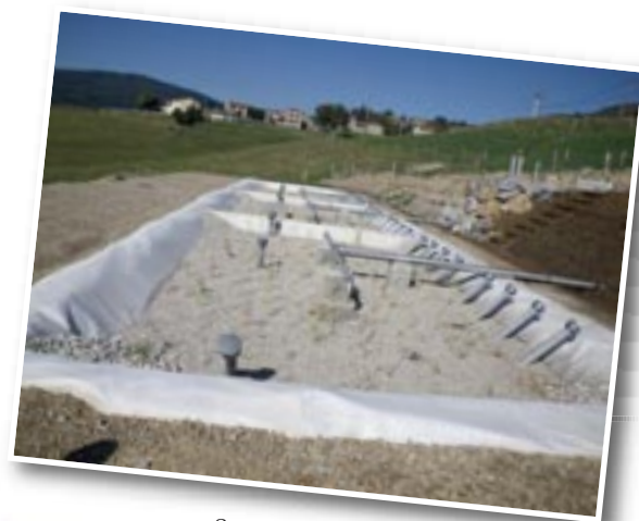
Station d'épuration du hameau de la Batterie à Graix
