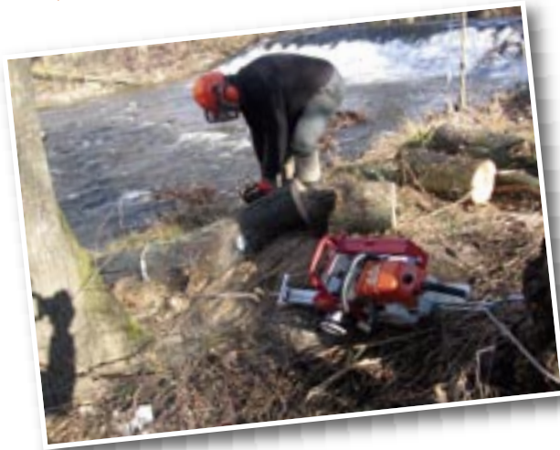
Abattage d'arbres en berge sur la Deûme - Boulieu
