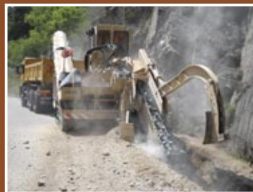
Réalisation de la tranchée pour la mise en place de la canalisation de transfert entre Villevocance et Annonay
