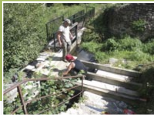
Réalisation d'une passerelle sur le canal - Villevocance
