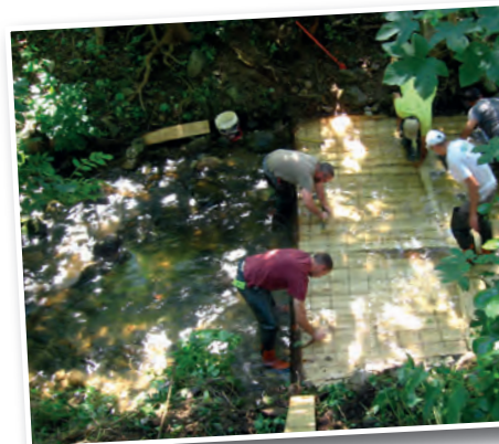
Mise en place d'un seuil piscicole sur la Cance à Vocance
