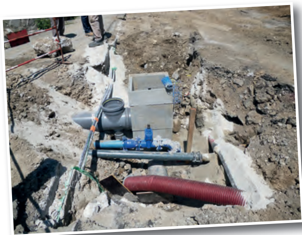
Mise en séparatif des réseaux à Annonay (Montée des Aygas)
