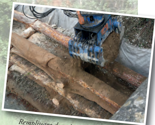
Remplissage du caisson avec de la terre
