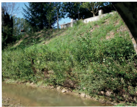
Le site après les travaux
