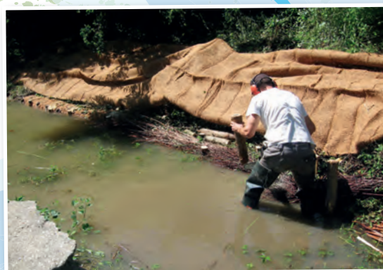
Aménagement des berges du Torrenson à St Etienne de Valoux
