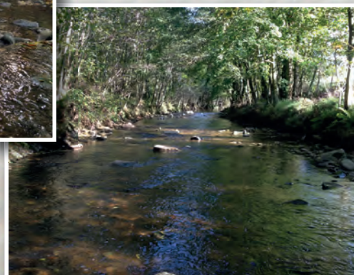
La Deûme à la Garinière à St Marcel après la pose des blocs
