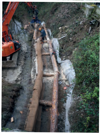
Mise en place du caisson en rondins de bois sur le Torrenson à Andance
