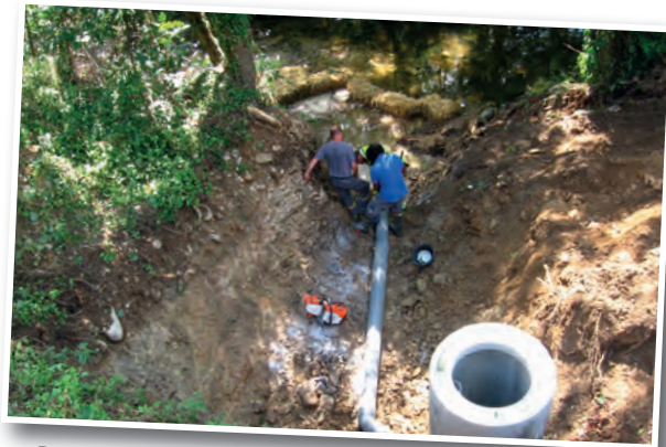
Déplacement de la canalisation du cours d'eau en berge
