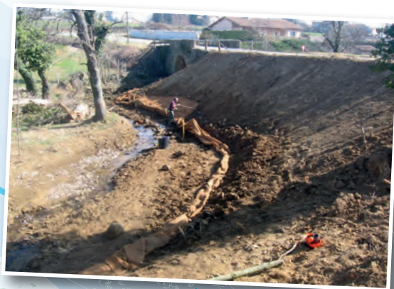
Aménagement des berges en technique de génie végétal sur le Torrenson à St Cyr
