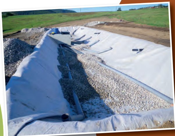
Mise en place de matériaux filtrants sur la station d'épuration de Boucieu à Annonay
