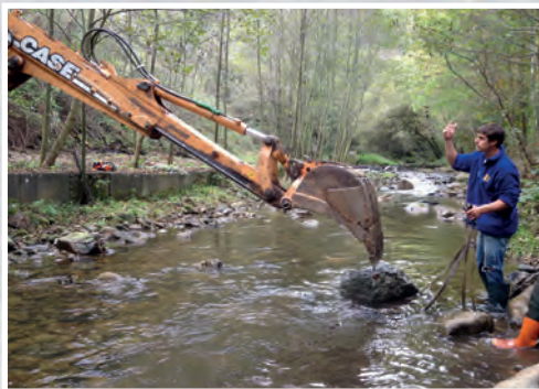
Pose de blocs dans la Cance à Galléliaure
