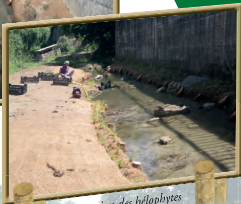
Mise en place de boudins de géotextile en rive gauche et des déflecteurs en rive droite
