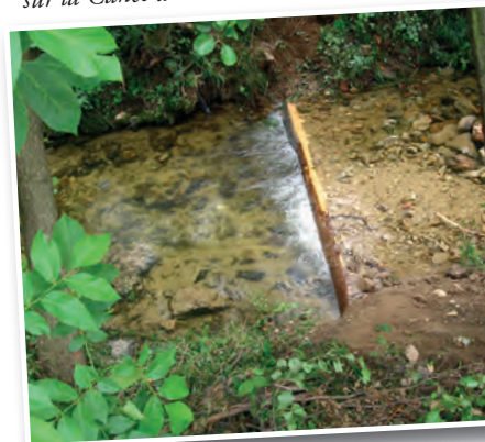
Seuil piscicole terminé
