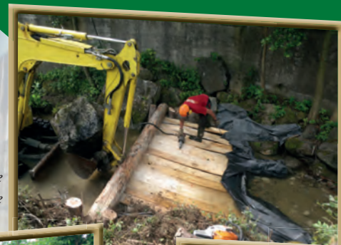
Mise en place d'un seuil piscicole
