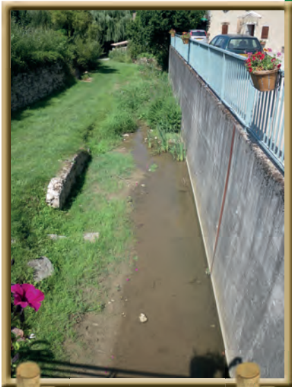
Le Torrenson dans le bourg de St Etienne de Valoux avant les travaux
