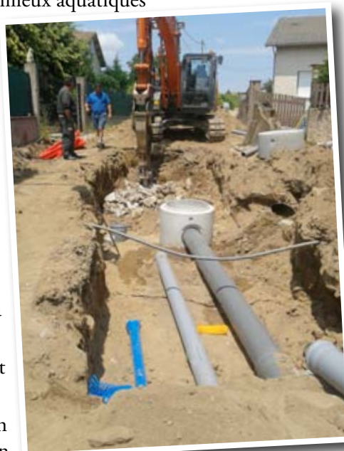
Suivi de travaux d'assainissement à Peaugres
