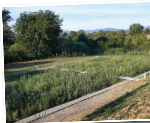
Filtres plantés de roseaux à Vernosc
