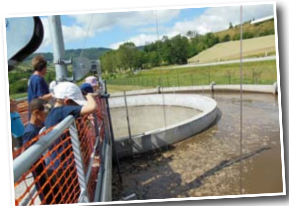
Visite de la station d'épuration de Bourg-Argental
