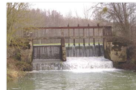
Vannes du bars de décharge du moulin Cassevesce
