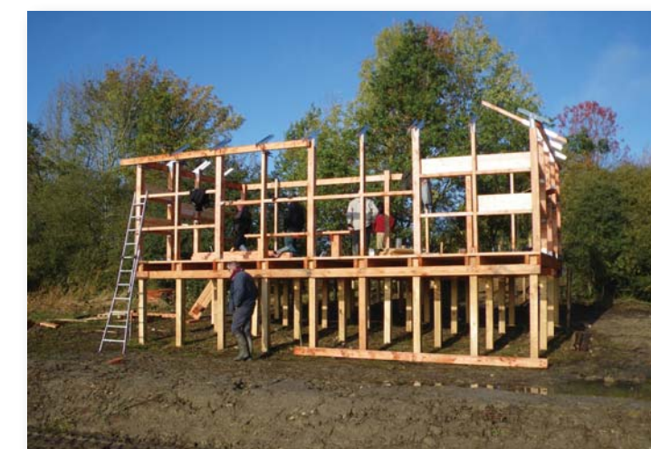
Observatoire ornithologique en cours de construction
