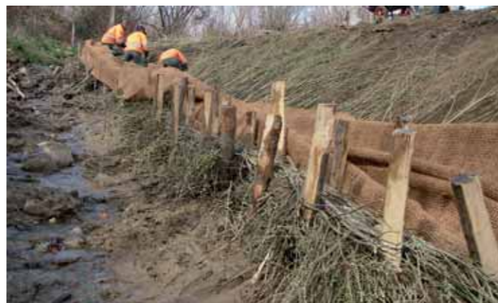
Stabilisation de berges par tressage, réalisée par l'équipe rivière.
