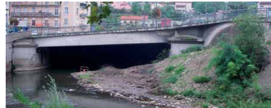
Suppression de la rampe d'accès.
