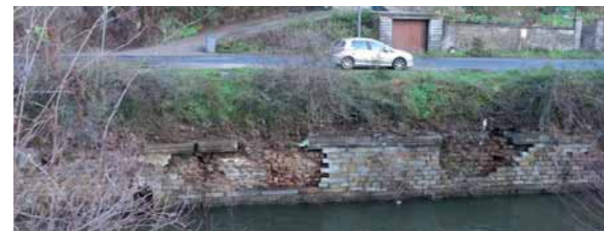
Reconstruction d'un mur à Rive-de-Gier.
