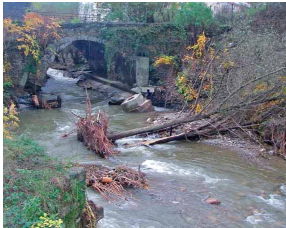
Travaux de 1 ère urgence à Lorette sur le Dorlay.
