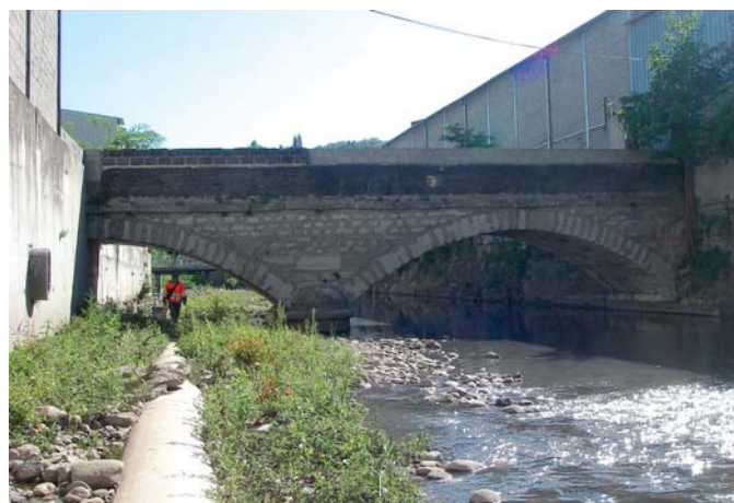
Pont de la verrerie avant travaux
