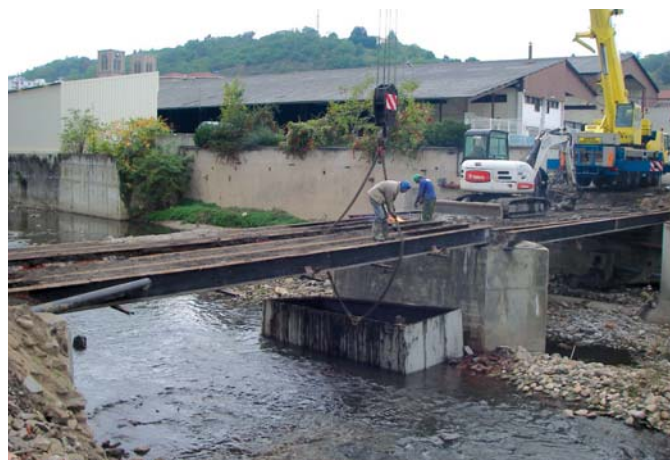
Démolition du pont de la rue Hémain
