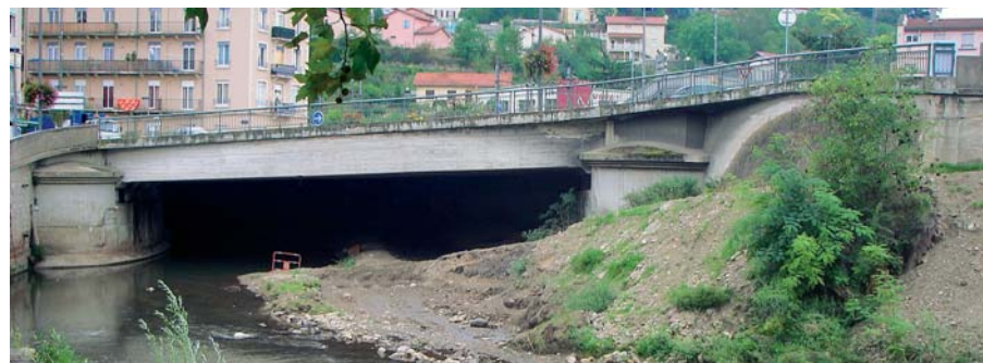
Démolition de la rampe
